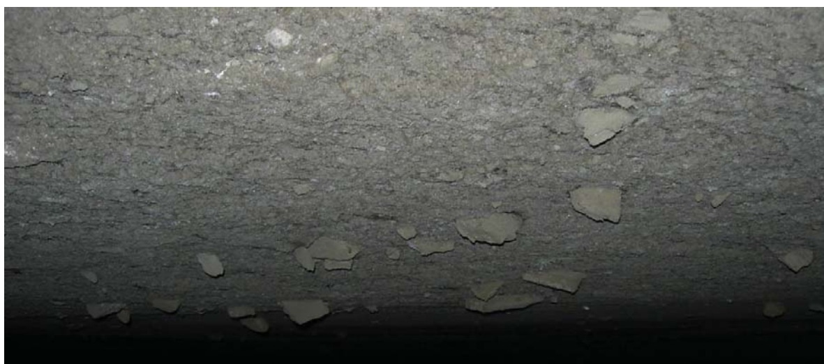
Рис. 10. Стелина (склепіння) луговні № 10 із субгоризонтальною куполоподібною поверхнею з чисельним включенням нерозчинних уламків
