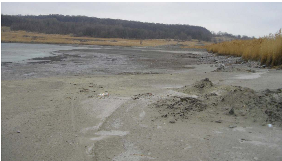
Рис. 7. Вихід на денну поверхню флотаційних вапняків флотації у північній частині хвостосховища №2
